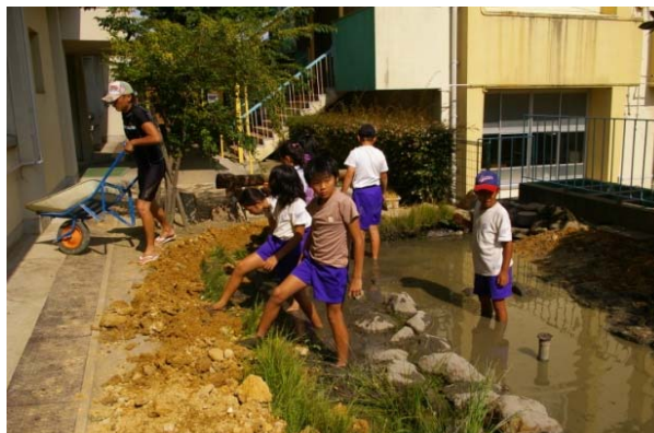
図-3 児童が土を締め固めている様子 (2013年7月23日)
