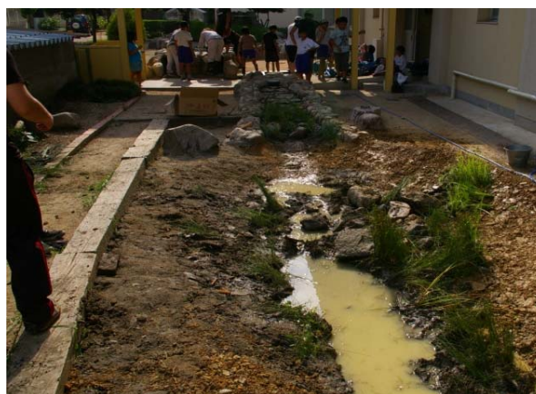
図-4 第一回再生工事後の西側 (2013年7月23日)
