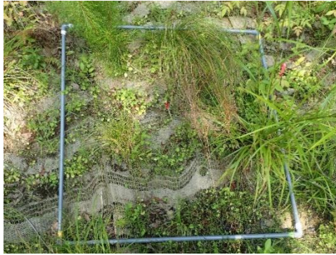
写真 1. 保護ネットの有る法面
